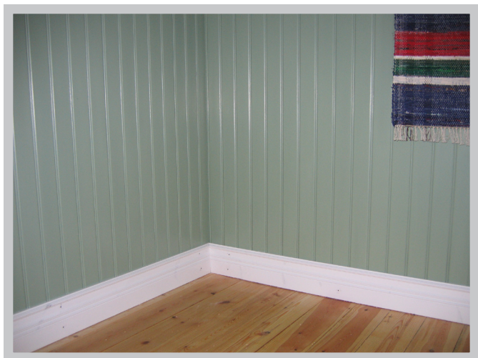
En före- och en efterbild. På "före-bilden" har man upptäckt att golvet inte behöver brytas upp. Det räcker med att dreva och täta vid socklarna. "Efter-bilden" då är golvet slipat och oljat, socklarna är på plats och panelskivorna är målade.
