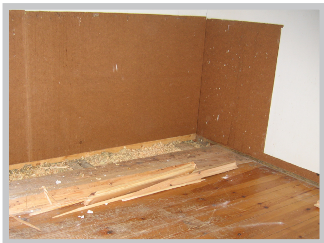
En före- och en efterbild. På "före-bilden" har man upptäckt att golvet inte behöver brytas upp. Det räcker med att dreva och täta vid socklarna. "Efter-bilden" då är golvet slipat och oljat, socklarna är på plats och panelskivorna är målade.
