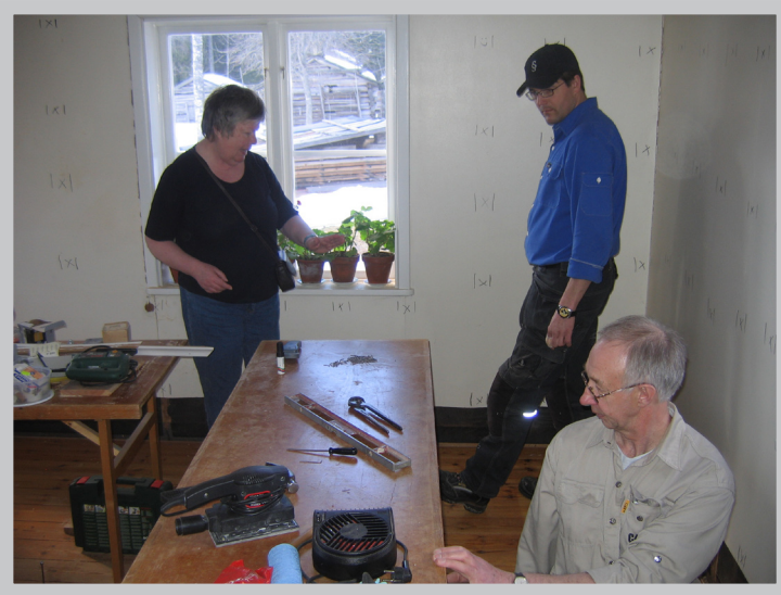
Här har Ragnar och Anders markerat alla regler i väggarna så att det är enkelt för killarna från Stömne att borra hål och spruta in isolering i väggarna.
