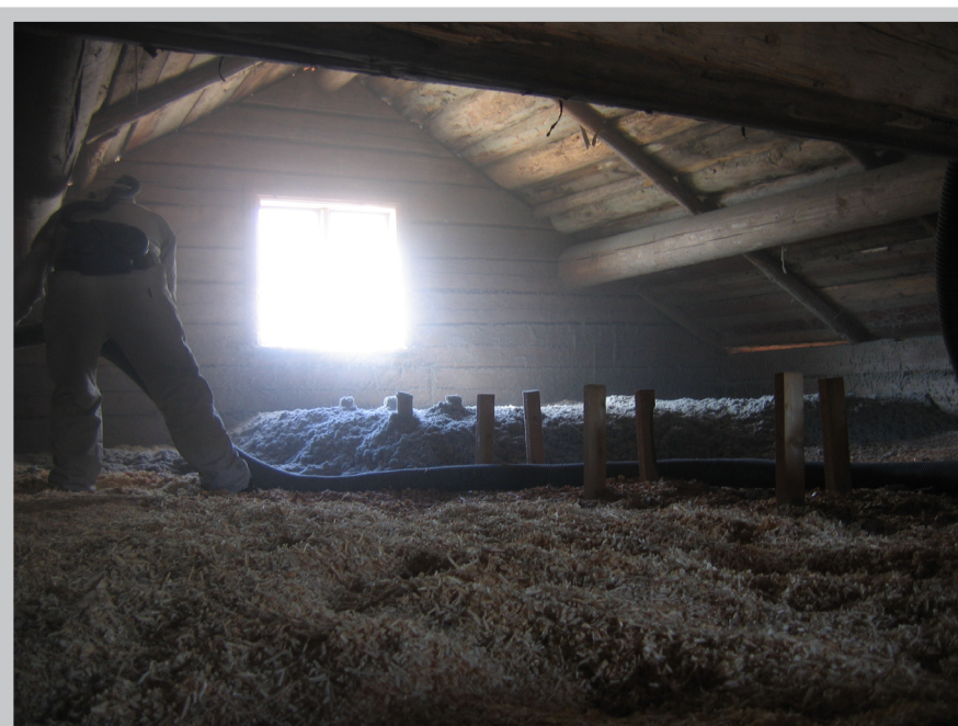
På vinden låg ett lager med spån, det behövdes också att Ragnar och Anders lindrevade i väggarna och fyllde på med spån. Därefter tog Stömne över och fyllde på med ett 50 cm lager av isolering.
