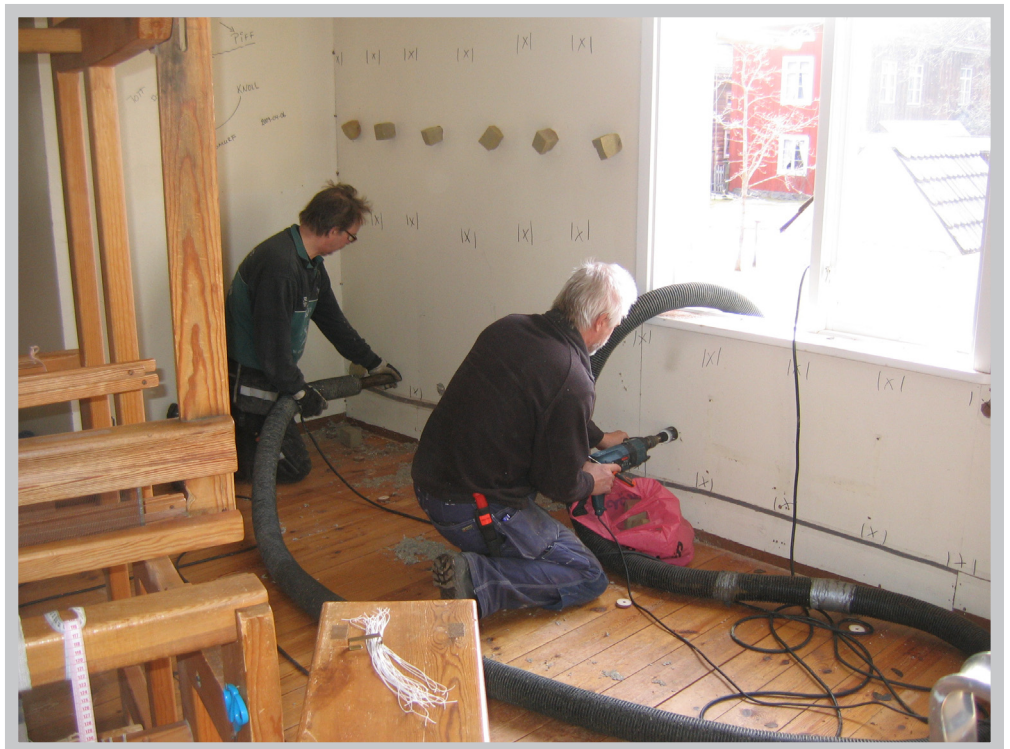
Man borrar hål med en dosbora och sedan använder man en slags omvänd dammsugare för att spruta in isoleringen.
