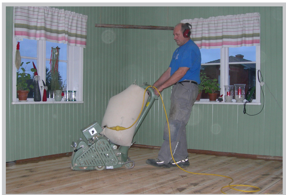
Golven slipades och oljades av Leanders golv från Alfta. Här arbetar Bengt-Olov med slipning av golvet i köket.
